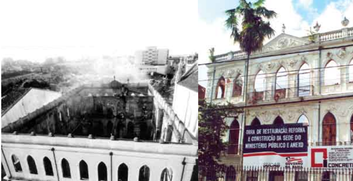
Incêndio e restauração da sede principal Fonte: Arquivo/Ascom-MP
