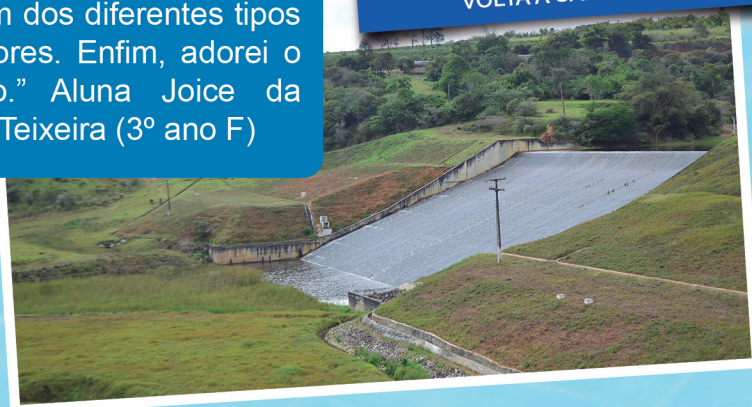
BARRAGEM DE ÁGUA FRIA II VOLTA A SANGRAR
